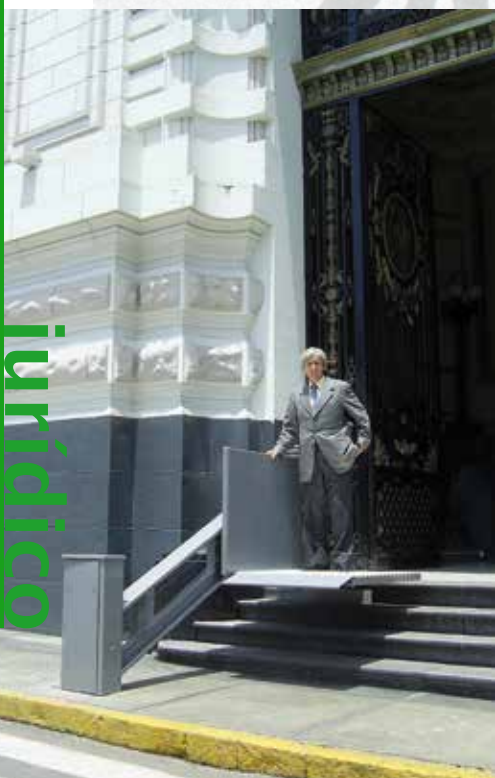
Rampa elevadora en un edificio
