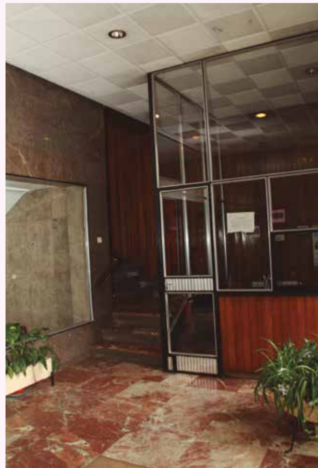
El edificio tiene siete escalones entre el hall y el ascensor
